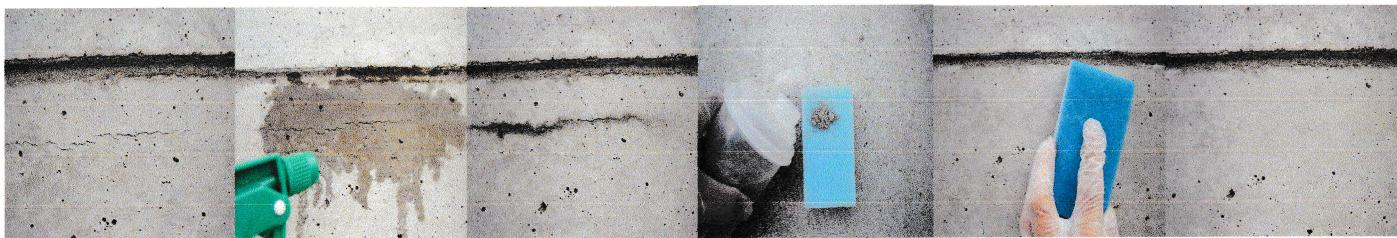
ひび割れ → 水湿し → ひび割れ部黒く湿った → 材料乾燥スポンジ上に少量→ 軽くあてすりこみ→ 完了
